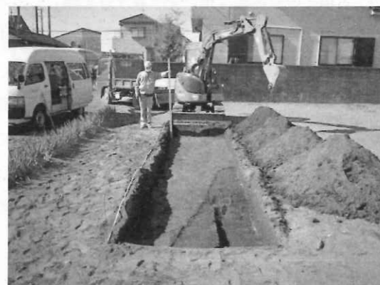
試掘調査状況
